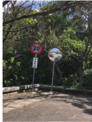
進入校門S型坡道，設置減速標誌及凸面鏡
